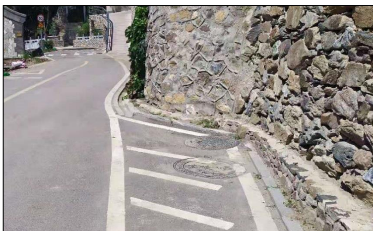
图2 本项目化粪池照片
