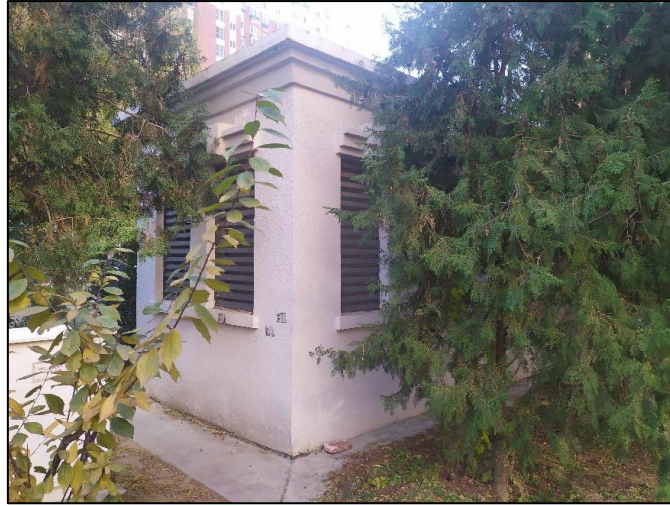
图4-2 地下车库排气筒
